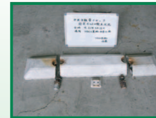
②ボルト撤去
